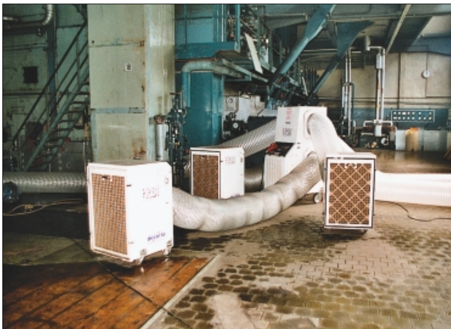
Abb. 4. Raumlüftung über Filter.
