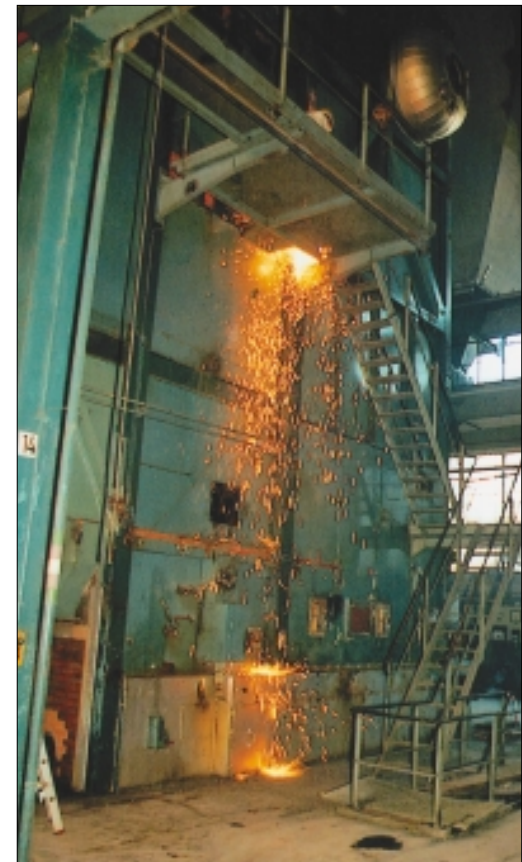
Abb. 3. Brennarbeiten im Kesselhaus.
