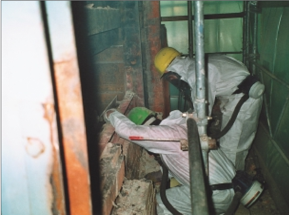
Abb. 2. Arbeiten im Schwarzbereich.
